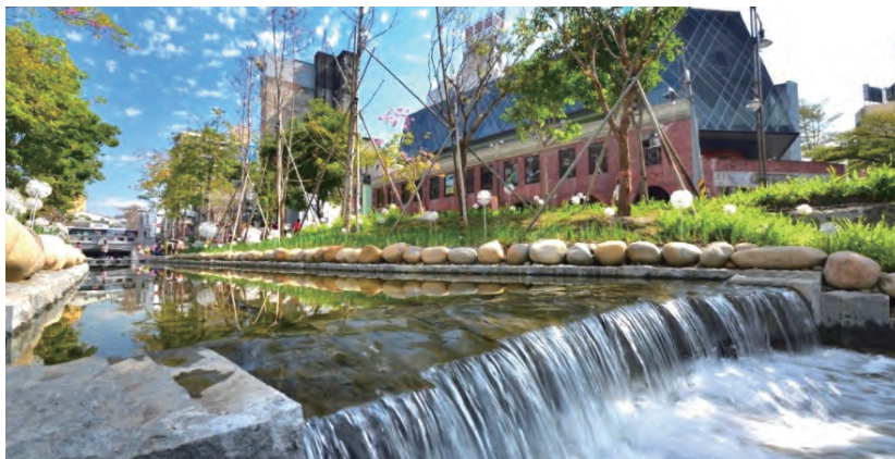
全國水環境改善計畫 - 臺中綠川污水截流及環境營造
